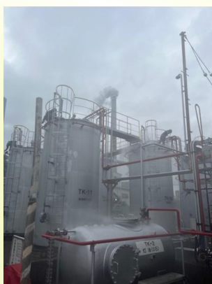
タンク散水ノズル清掃実施
