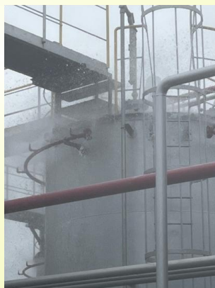
タンク散水ノズル清掃実施
